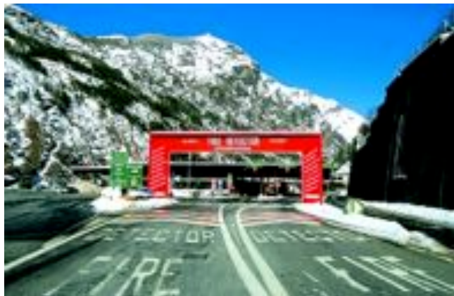
L'accesso autostradale del Frejus
