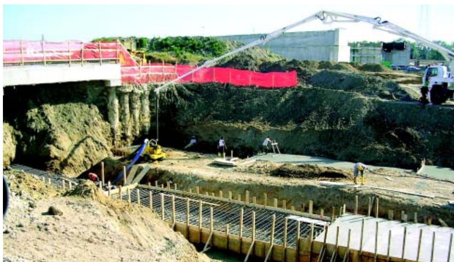
Getto della soletta e delle paratie per il sottopasso della A8
