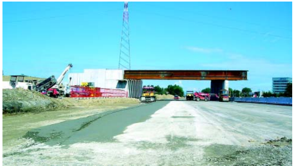
Il cantiere dei nuovi svincoli sulla A8, con la prima campata del ponte e una delle nuove carreggiate laterali
