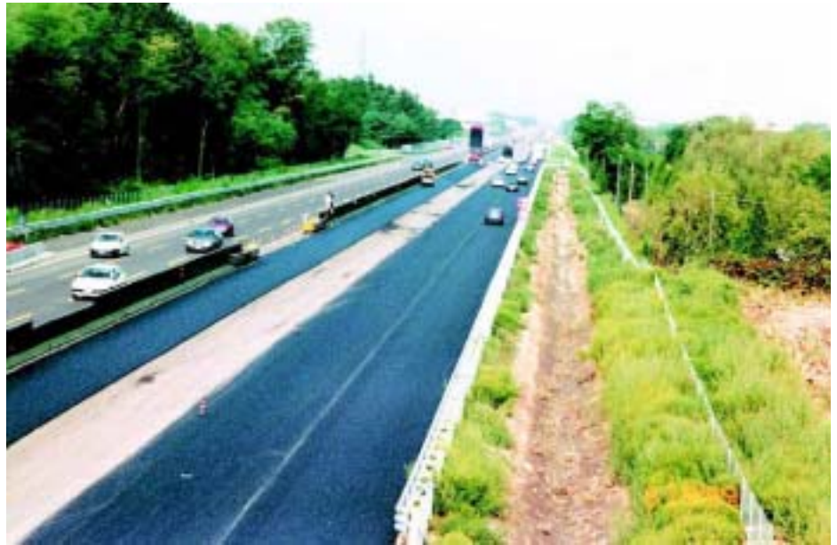
Vedute dei lavori di ampliamento dell'autostrada Milano-Laghi, realizzati nel corso del 1999
