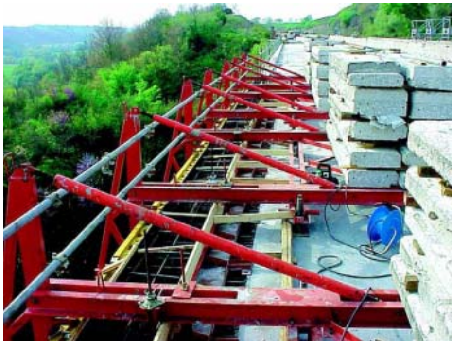
Particolari dei lavori di allargamento di uno dei viadotti principali della Orte-Fiano
