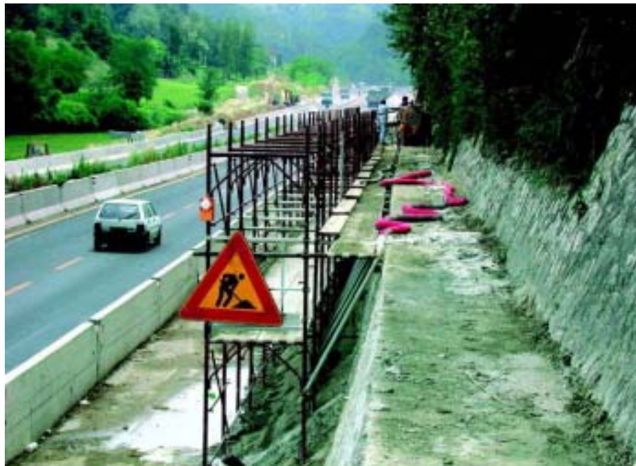
Vedute dei cantieri per l'ampliamento del tratto Orte-Fiano Romano dell'Autostrada A1
