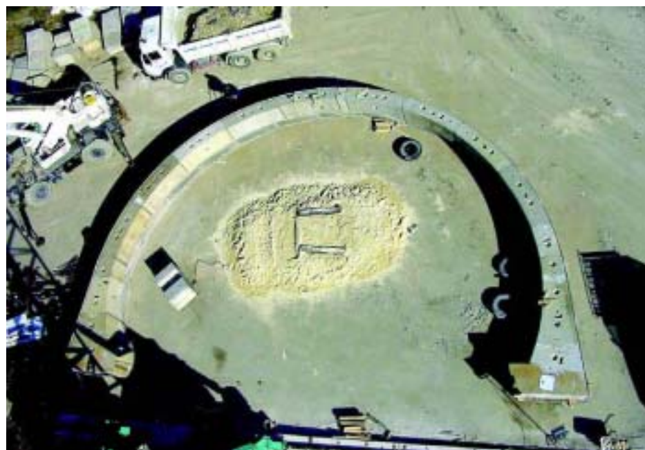
Prova a terra del montaggio del rivestimento autoportante
