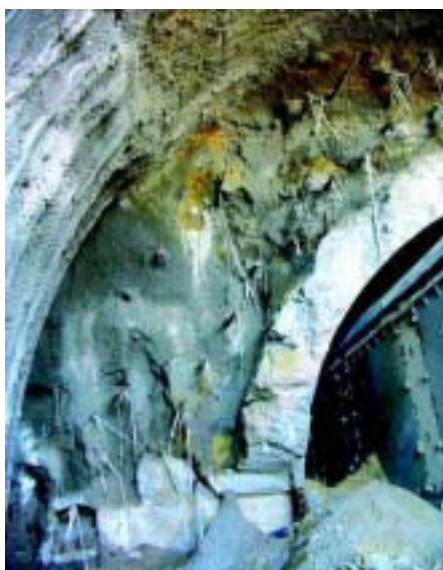
Particolare delle opere di consolidamento del fronte di scavo
