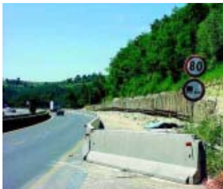
Particolare di un cantiere di adeguamento autostradale sotto traffico
