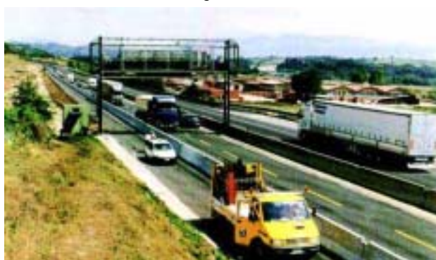
Particolare di un cantiere di adeguamento autostradale sotto traffico
