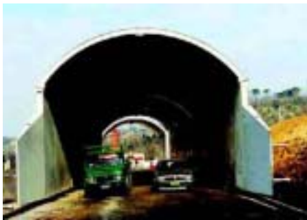
Montaggio dello scudo di protezione del traffico
