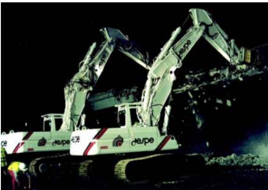
Particolare dei lavori di demolizione nel tratto Modena-Bologna dell'Autostrada del Sole
