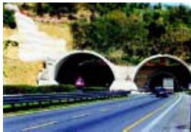
Sistemazione dei portali scarificali, 500 metri prima dell'imbocco delle gallerie
