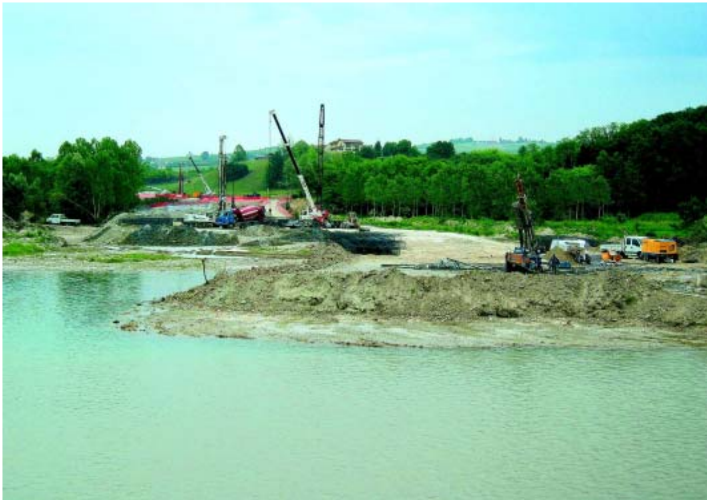
Vedute del cantiere del viadotto Tanaro dell'Asti-Cuneo
