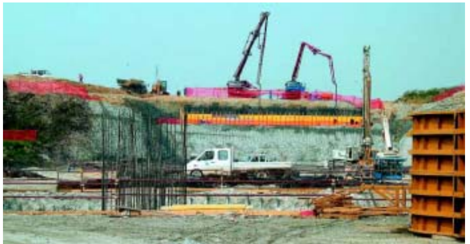
Particolari dei lavori di costruzione del viadotto Tanaro dell'Asti-Cuneo
