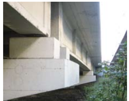
Esempio di pulvini allargati per consentire il movimento di un viadotto in zona di frana
