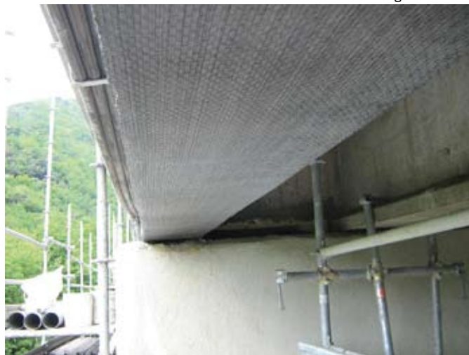
Rinforzo con fibre di carbonio dell'intradosso di travi degradate
