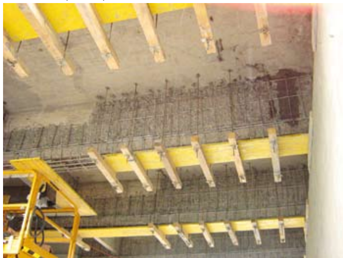
Particolare di cassaforme sospese alla soletta e armature in acciaio inox per il ripristino di travi in calcestruzzo
