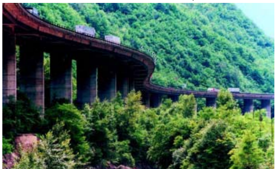
Particolare del Viadotto Campodasso dell'A22 del Brennero
