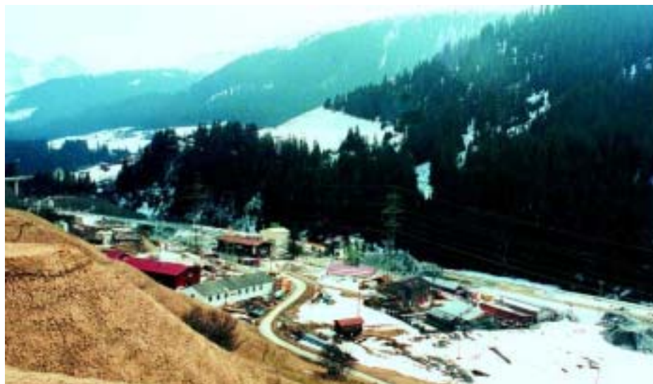
Particolare del cantiere di Sedrun della galleria di base del Gottardo
