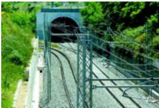
Galleria Vasto lato nord
