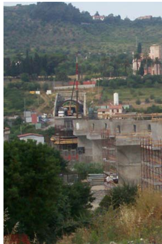
Veduta del cantiere del Viadotto Prino
