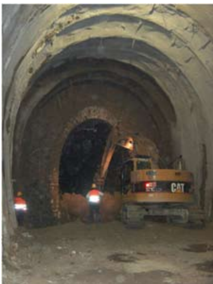
Particolari dei lavori di allargamento della galleria Castellano e della costruzione del suo imbocco sud
