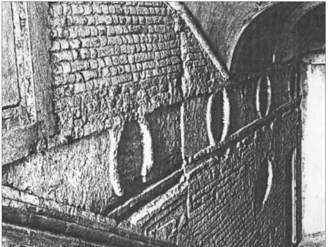
Particolare delle decorazioni in cotto scoperte sulla parete orientale dello scalone.
