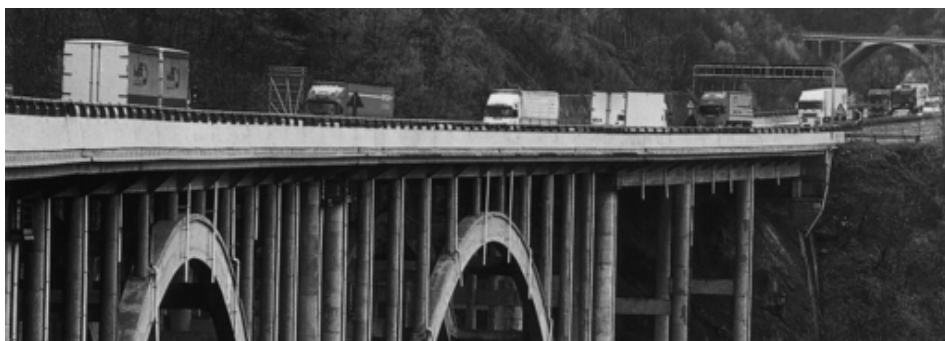
Particolare di uno dei viadotti sul tratto appenninico dell'autostrada A1.
