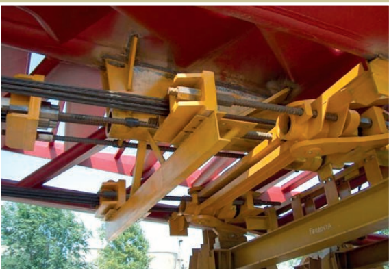
Particolare del dispositivo di ancoraggio dei cavi provvisori utilizzati per il trasporto
