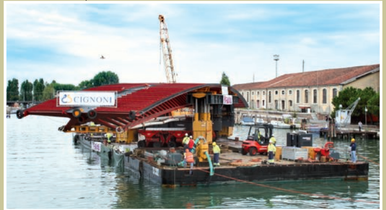
Particolare delle operazioni di avvicinamento e rotazione del concio centrale
