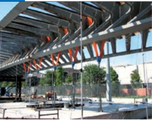
Particolare del sistema di trasduttori di spostamento utilizzati durante la prima prova di carico sul concio centrale del ponte
