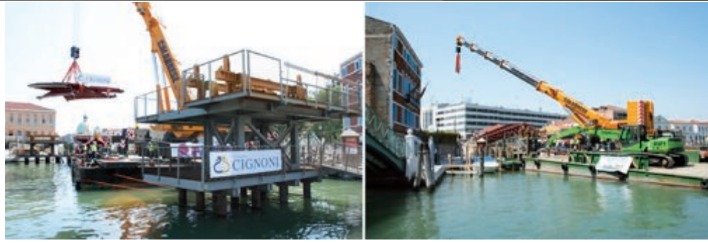
Montaggio dei due conci laterali e particolare dei sostegni provvisori per il conccio centrale
