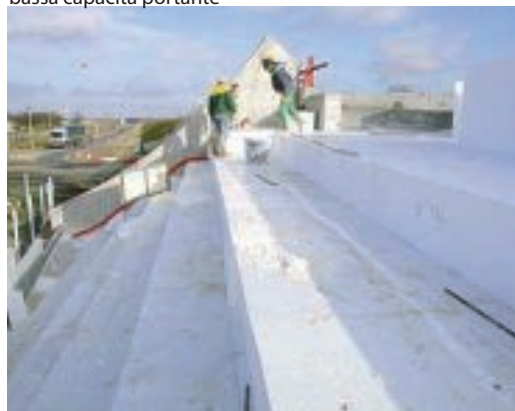
Costruzione di rilevati in polistirene espanso su terreni a bassa capacità portante
