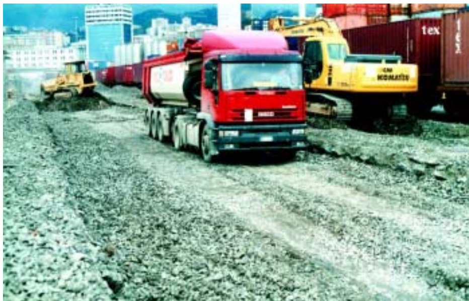
Genova: lavori sul ponte Etiopia
