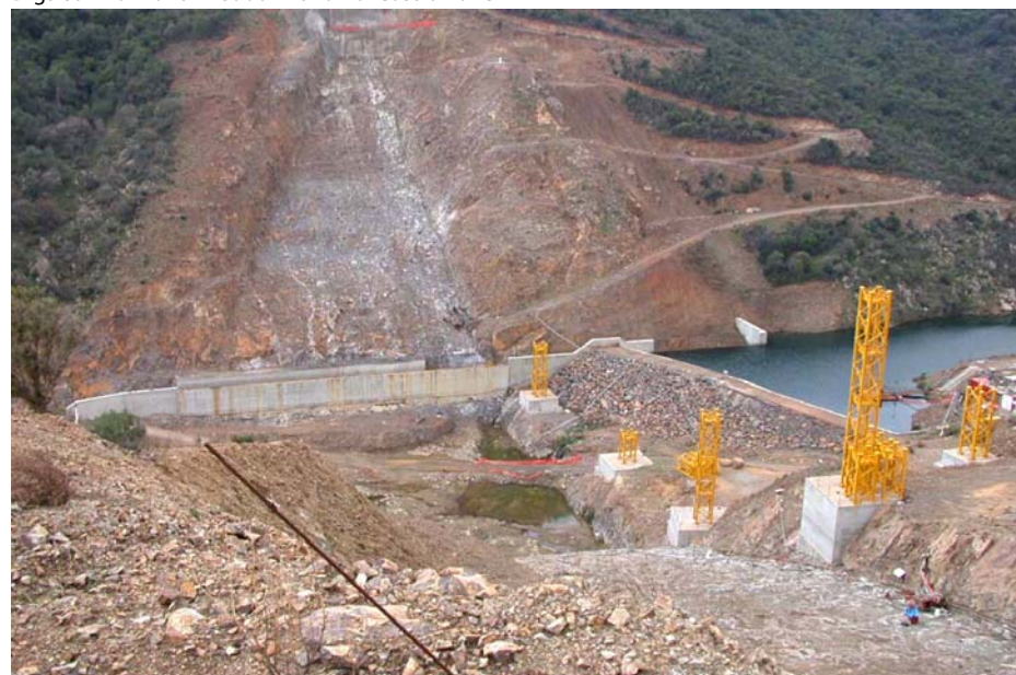
Diga sul Rio Monti Nieddu - Lavori di costruzione
