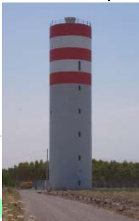
Vista del Torrino di sollevamento Margiani
