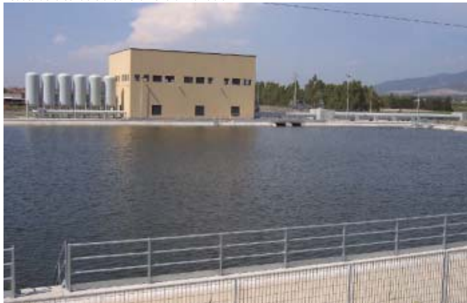
Veduta della centrale di sollevamenti di Marrubiu
