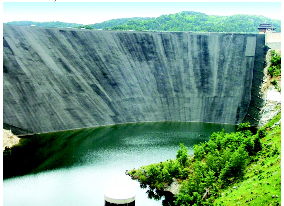
Particolare della diga del Menta
