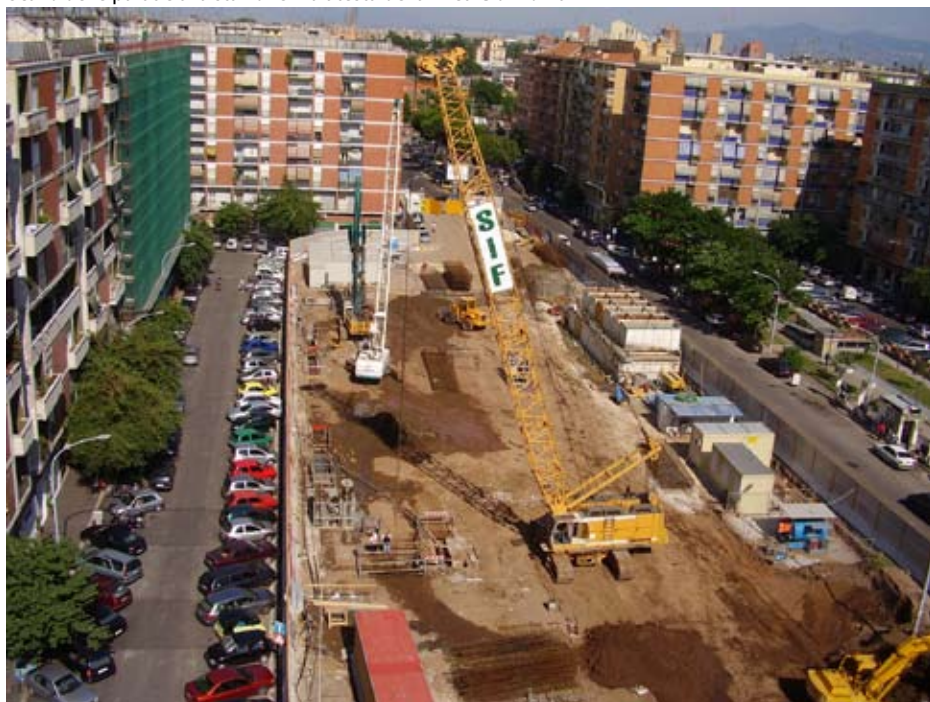
Scavo delle paratie alla stazione Malatesta della linea C di Roma
