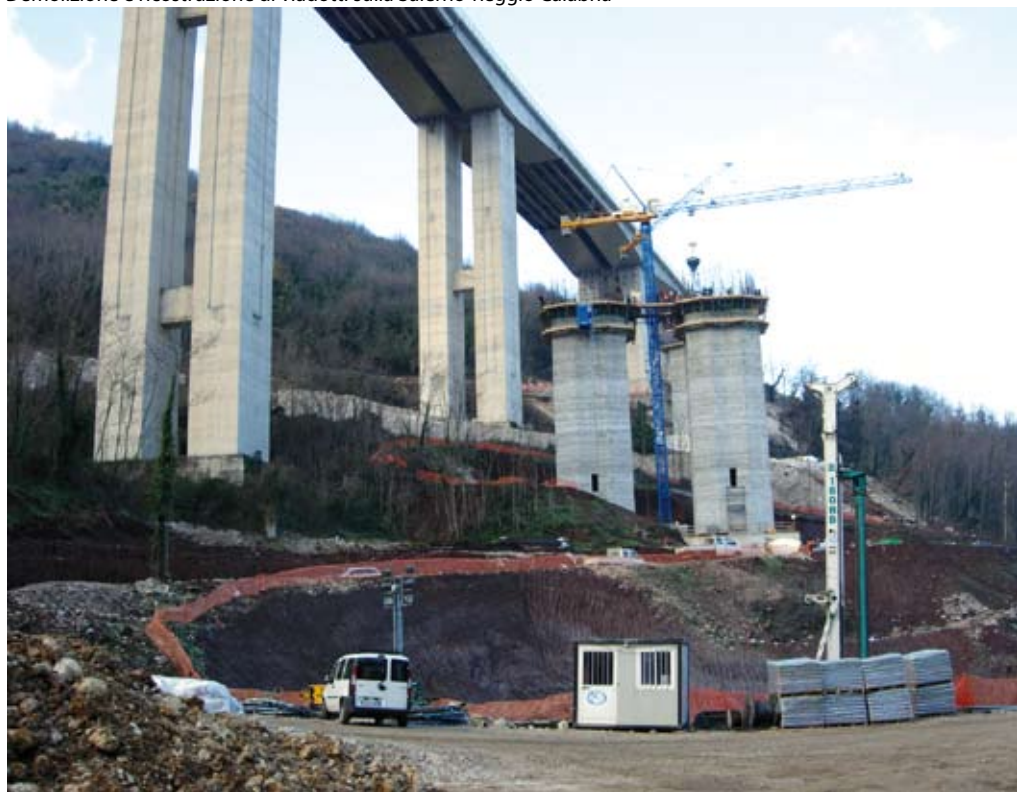
Demolizione e ricostruzione di viadotti sulla Salerno-Reggio Calabria
