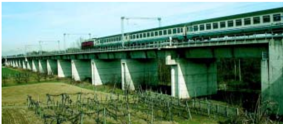
Il nuovo viadotto tra Nogara e Isola della Scala, parte del raddoppio e potenziamento in corso della linea Bologna-Verona
