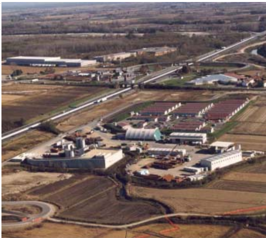
Veduta del Campobase di Greggio dei lavori per la linea per alta velocità Torino-Milano
