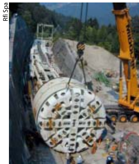
Particolare della macchina Tbm utilizzata per lo scavo della galleria Monte Zucco, la più importante opera civile della variante al tracciato della ferrovia Treviso-Calalzo, in fase di ultimazione
