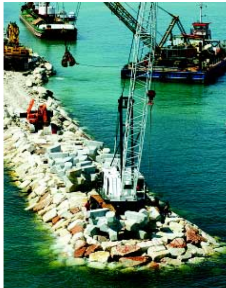
Mose di Venezia: lavori alle bocche di Malamocco
