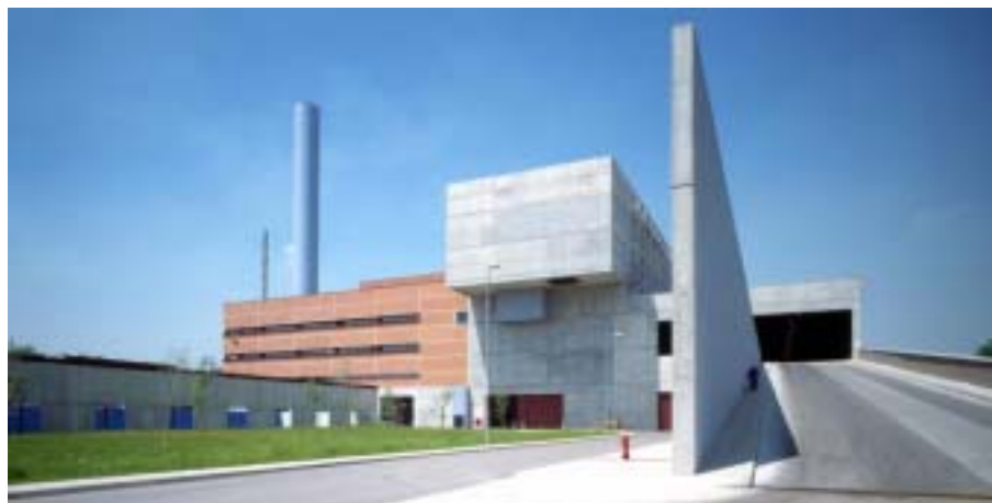
Particolare degli ingressi di Silla2
