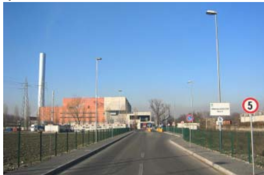
Ingresso del termovalorizzatore Silla2
