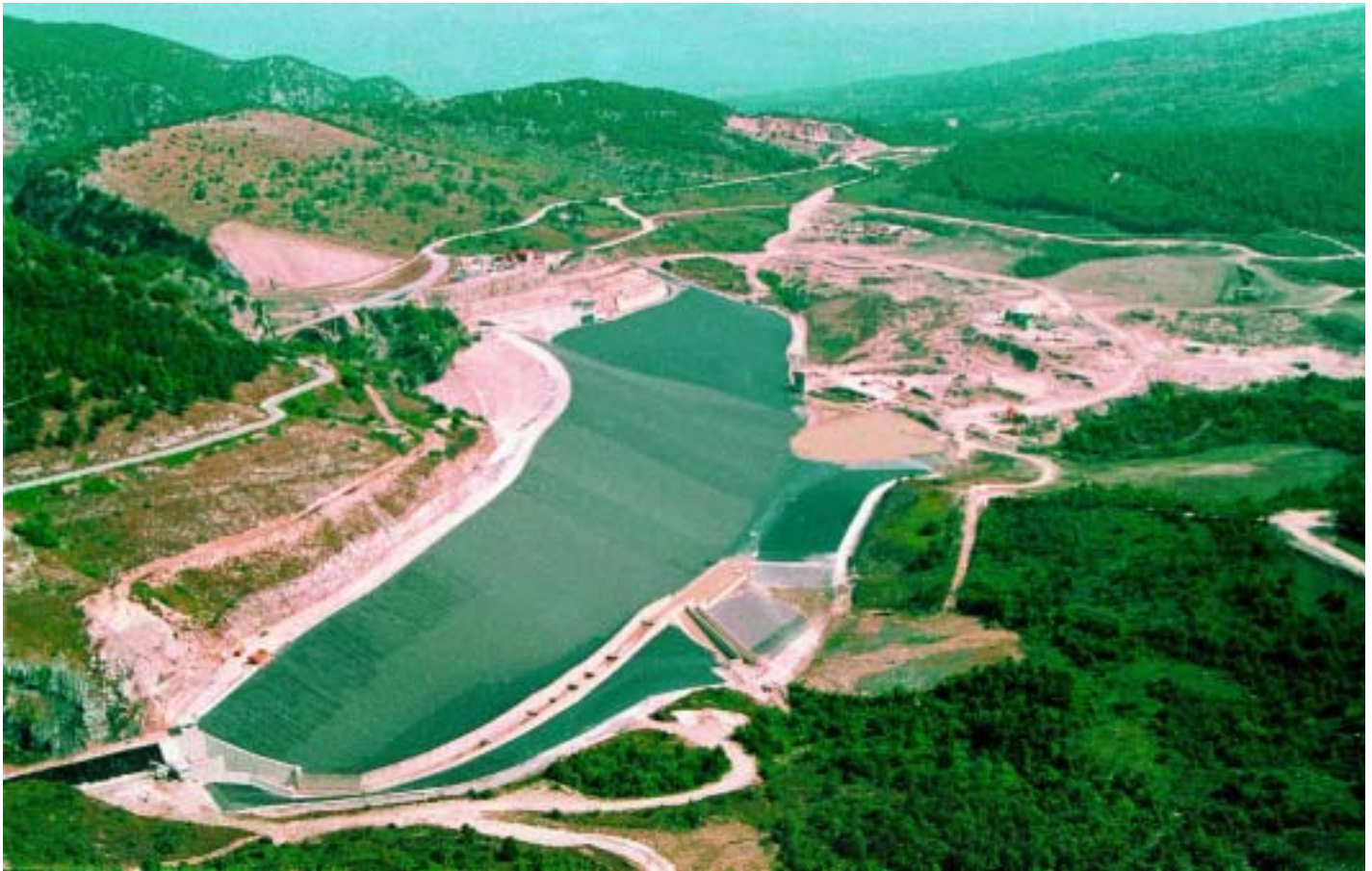
Diga di Arcichiaro sul torrente Quirico, importante riserva idrica per il Molise
