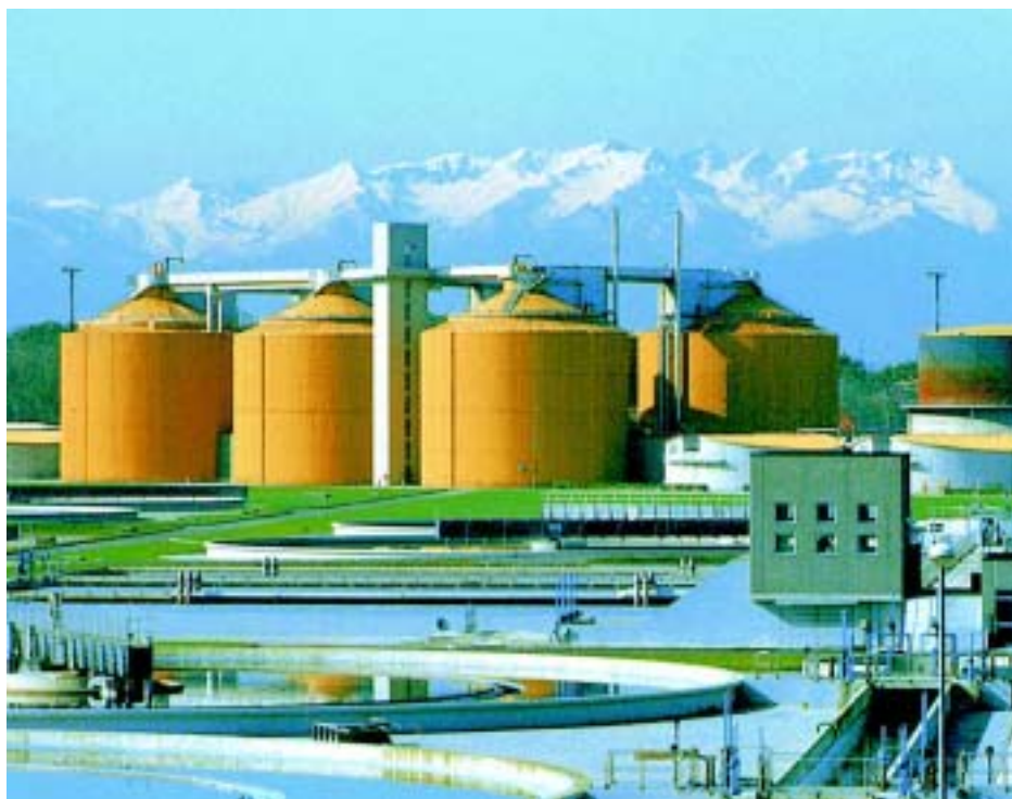
Impianto di depurazione di Torino
