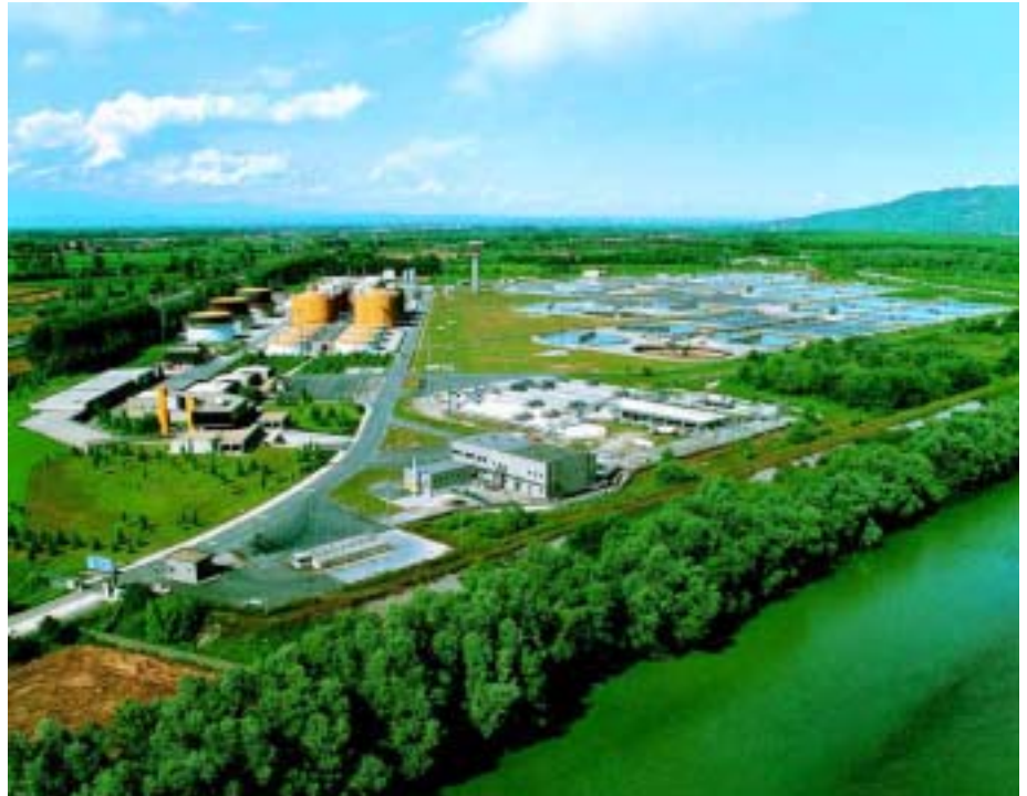
Veduta generale dell'impianto di Torino
