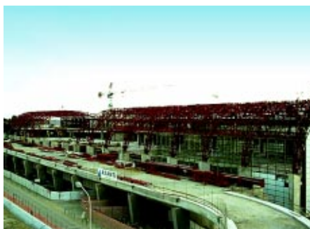
Aeroporto di Cagliari: lavori al terminal
