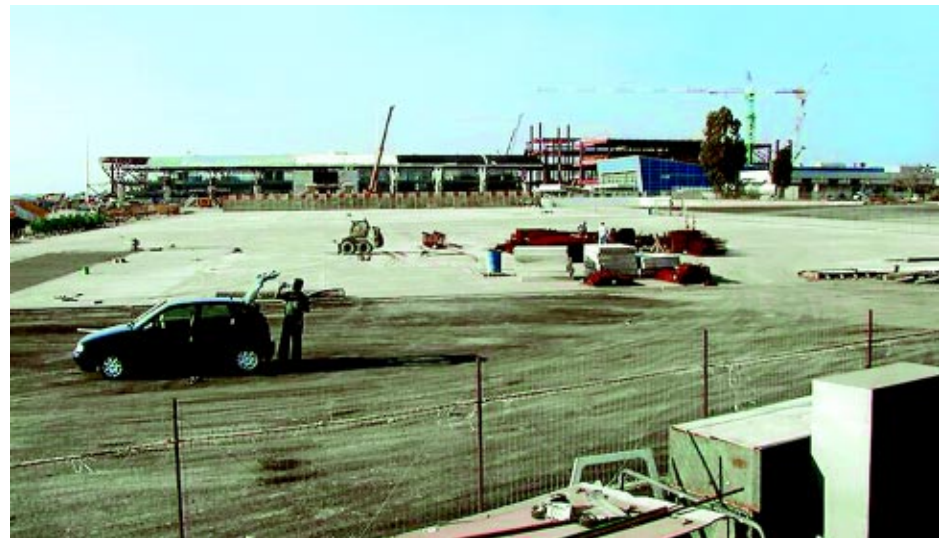
Aeroporto di Cagliari: lavori nel piazzale
