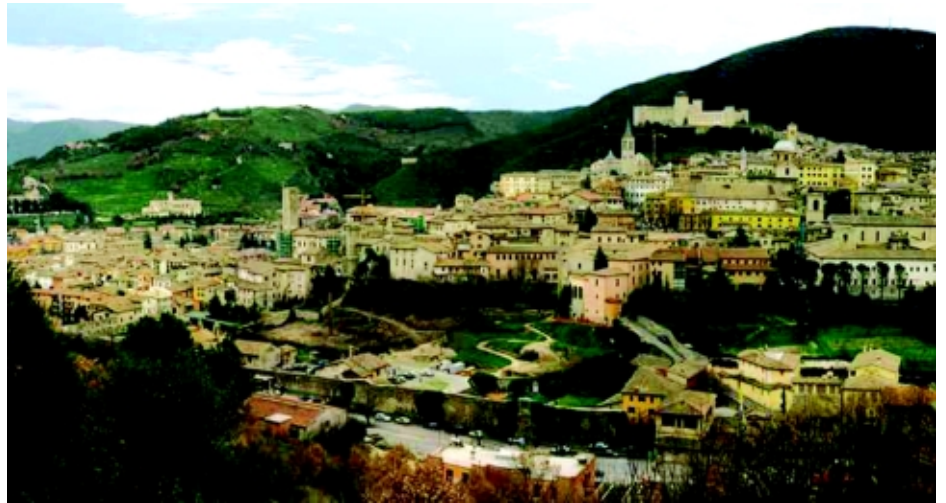
Veduta di Spoleto all'inizio dei lavori di scavo del primo percorso pedonale meccanizzato
