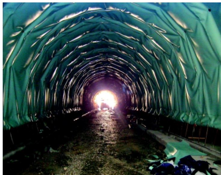
Particolari del consolidamento in superficie e dell'impermeabilizzazione del percorso meccanizzato che attraversa da sud a nord il centro storico di Spoleto
