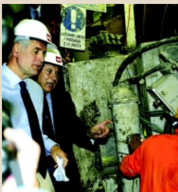
Roberto Formigoni sul cantiere della metropolitana che collegherà il nuovo polo fieristico di Milano
