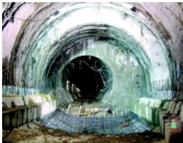
Particolare dei lavori per la stazione Quattro Venti di Roma
