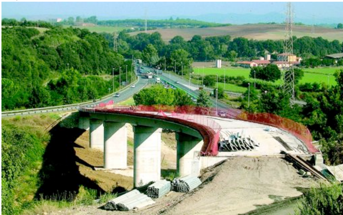
Lavori per la terza corsia del Grande raccordo anulare di Roma
