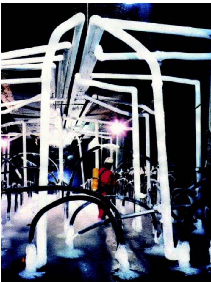
Particolare del congelamento effettuato alla stazione Crocetta della linea 3 della metropolitana di Milano alla fine degli anni Novanta
