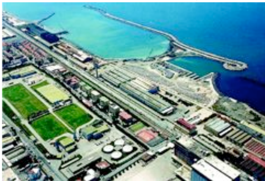
Nuovo porto della Marina di Stabia
