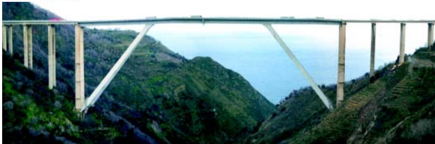
Veduta del viadotto Sfalassà
