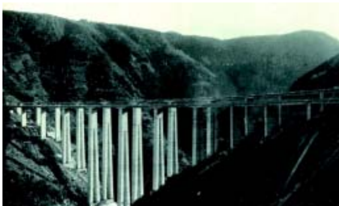
Veduta del viadotto Favazzina negli anni Settanta
