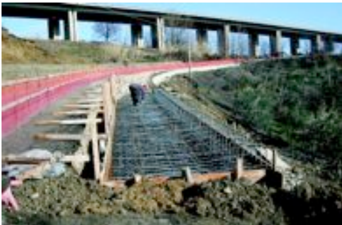
Particolare dei lavori sulla Statale 491
