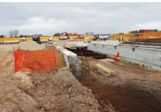
Particolare di lavori alla stazione Giardinetti
