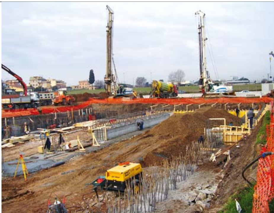
Veduta del cantiere della stazione Giardinetti
