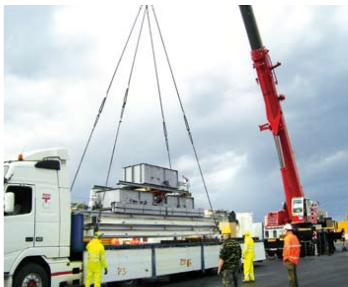
Consegna in cantiere di altre parti della prima Tbm
