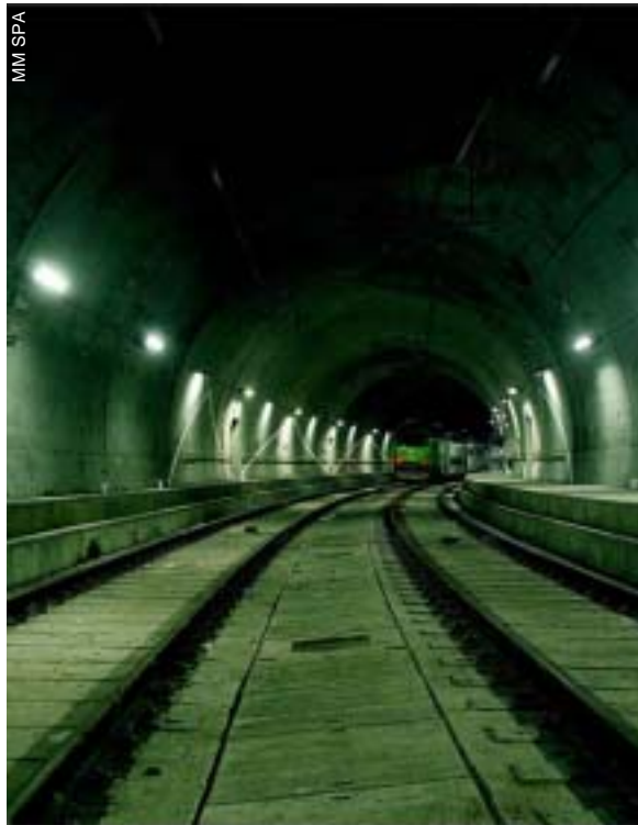
Veduta della galleria del passante di Milano presso la stazione Vittoria
