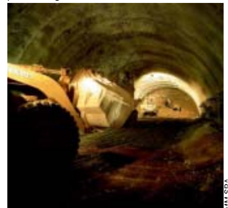
Scavo del prolungamento della metropolitana 3 presso Dergano
