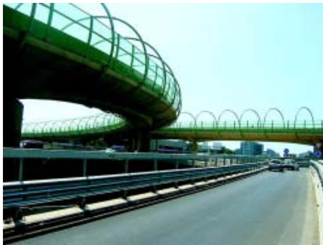
Particolare del nuovo svincolo di piazza Maggi
