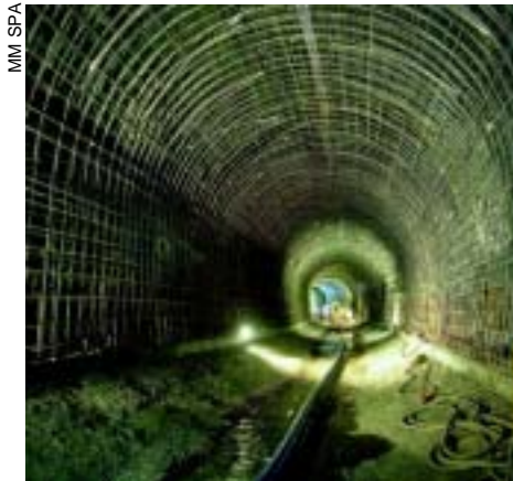
Lavori del prolungamento della metropolitana 2 verso piazzale Abiategrasso a Milano
