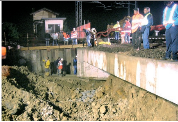
Particolare dei lavori per l'eliminazione dei passaggi a livello
