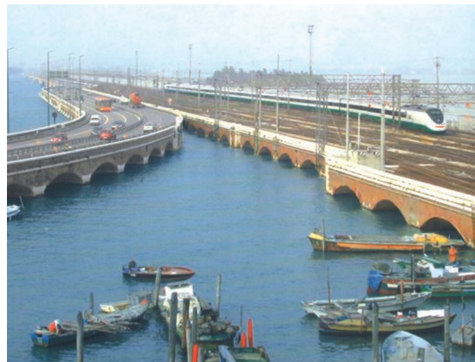
L'imbocco stradale e ferroviario al viadotto traslagunare
