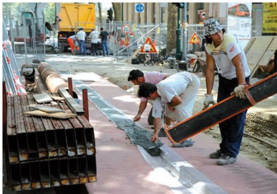
Posa del binario del nuovo tram di Mestre
