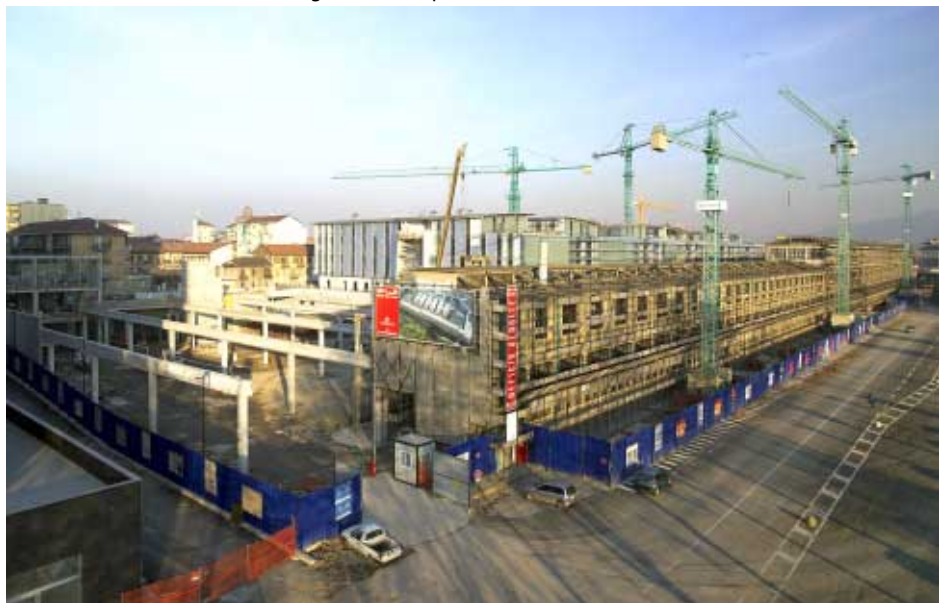
Veduta del cantiere nell'area Savigliano della Spina 3
