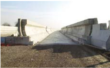
Particolare dell'impalcato del cosiddetto "Viadotto Modena"
