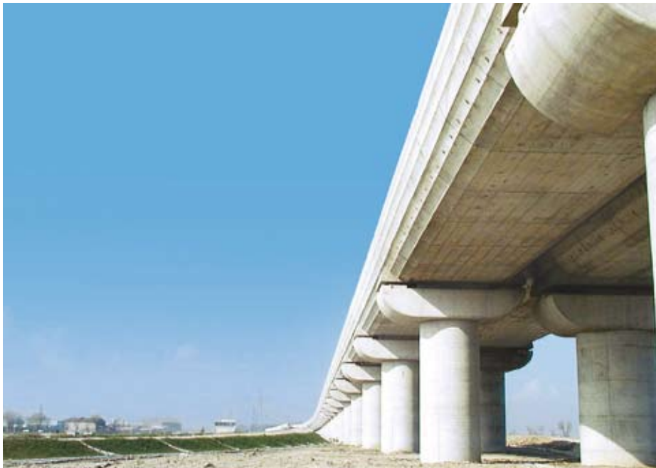
Particolare del viadotto della linea AV realizzata a nord della città
