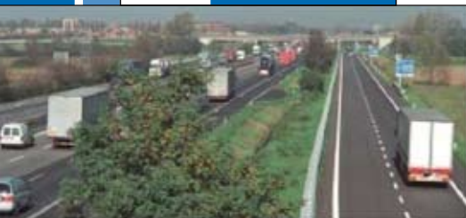
Veduta della Complanare già realizzata ai due lati della A4
