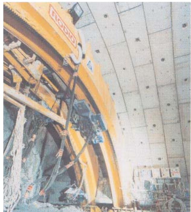
▲ Particolare della posa, con una macchina speciale, del rivestimento autoportante della galleria di stazione.
