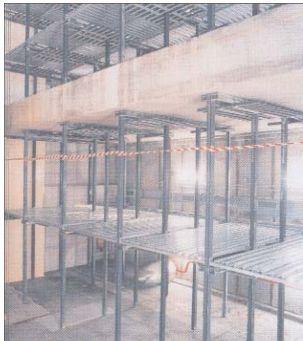
▲ Particolare dell'autosilo meccanizzato sopra la stazione Cornelia.
